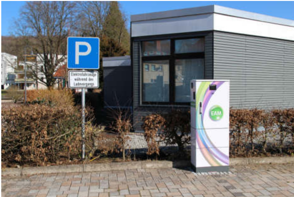
Abb. 30: E-Ladesäule in Hardegsen
