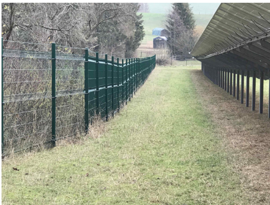
Abb. 11: Beispiel einer Zaunanlage inklusive Übersteigschutz
