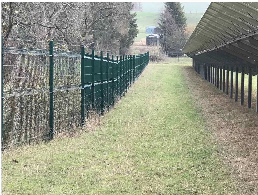
Abb. 10: Beispiel einer Zaunanlage inklusive Übersteigschutz
