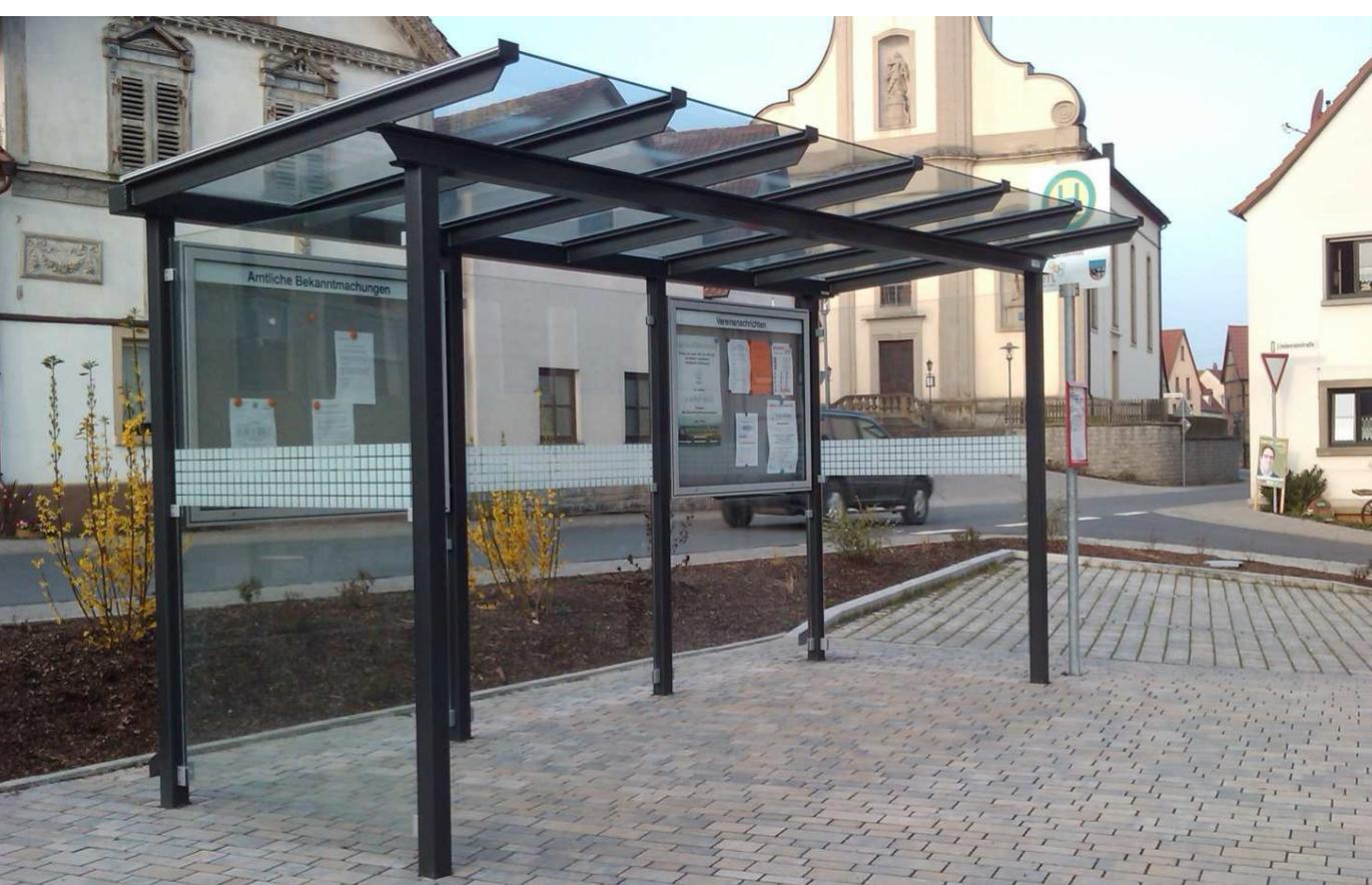
**Konstruktionen:** Quadratrohrstützen auf denen die Wasserkästen, Unterzüge und Dachhauptträger aus T- Profil montiert werden. Wasserkasten aus Stahlblech, mehrfach gekantet und ausgesteift.
