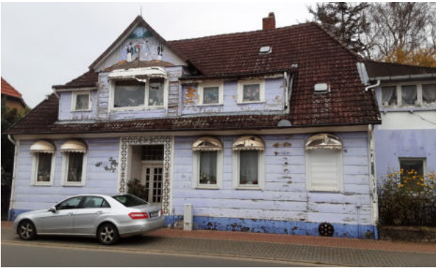
Hoher Sanierungsbedarf an der Fassade
