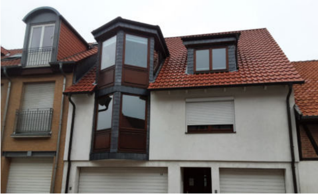
Guter Zustand des Daches
