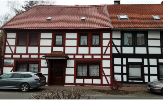
Kein bis geringer Sanierungsbedarf an der Fassade
