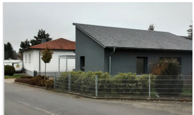
Gebäude mit Pultdach
