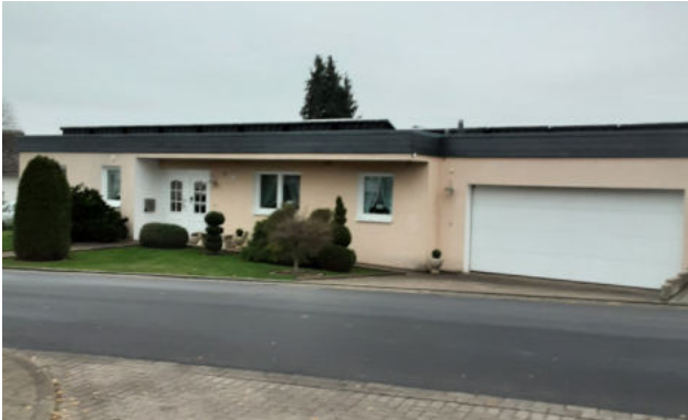
Gebäude mit Dach aus Kunststoff
