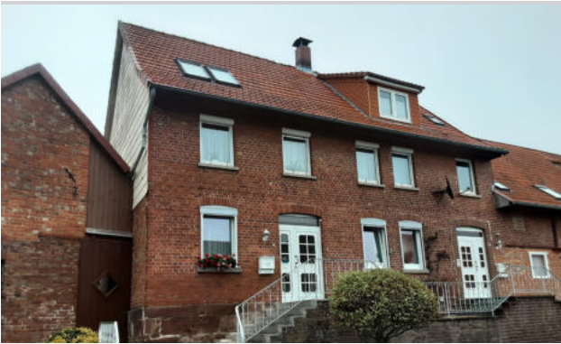
Gebäude mit Klinkerfassade
