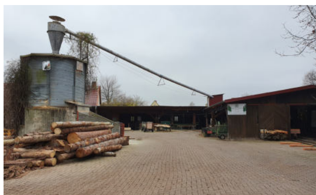
Abbildung 50: Holzverarbeitender Betrieb im Quartier
