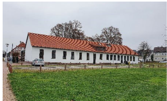
Abbildung 17: Stadthalle in Moringen
