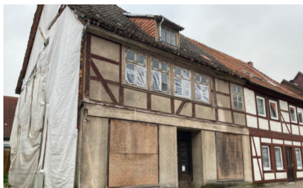
Abbildung 55: Gebäude mit hohem Sanierungsbedarf
