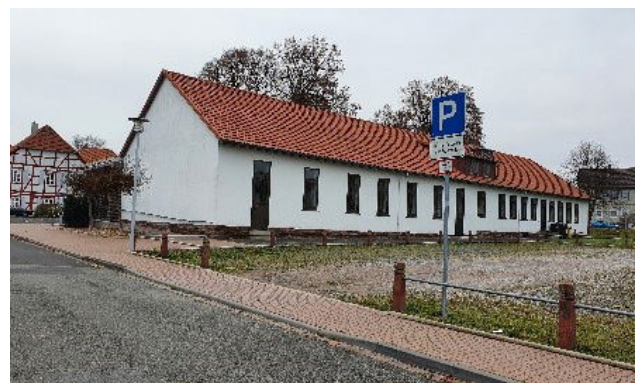
Abbildung 18: Stadthalle in Moringen
