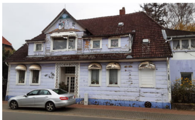
Abbildung 54: Gebäude mit hohem Sanierungsbedarf
