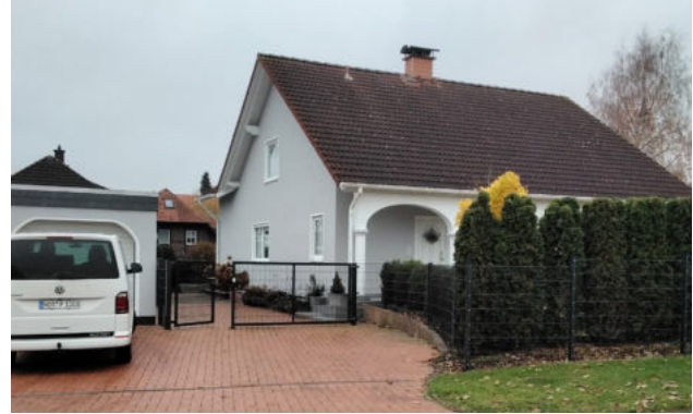
Dachzustand eher gut
