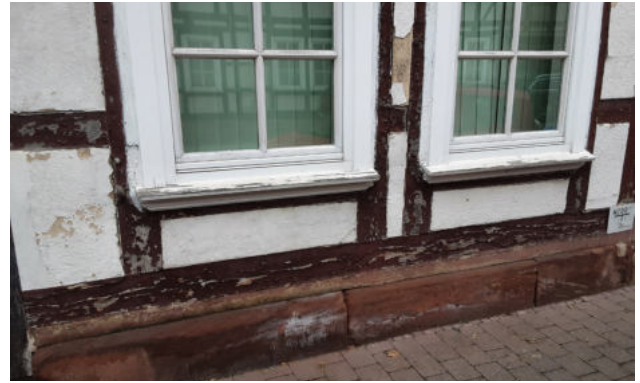
Mittlerer Sanierungsbedarf an der Fassade
