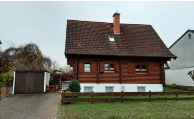
Dachzustand eher schlecht
