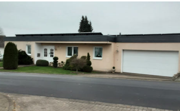
Gebäude mit Flachdach
