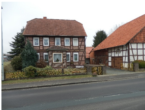
Wohnhaus mit angrenzenden Wirtschaftsgebäuden
