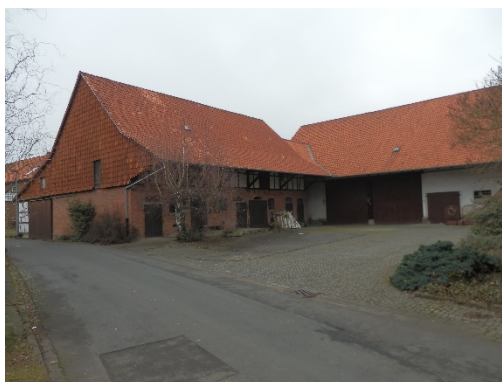
Wirtschaftsscheunen an der Schmiedestraße
