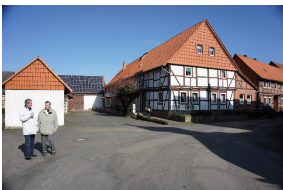
Dreiseithof im Nebenerwerb genutzt an der Behrener Straße
