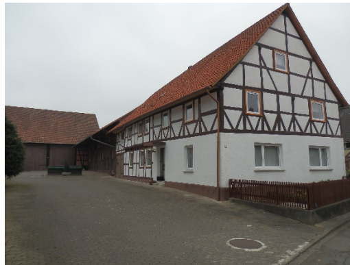
Wohngebäude mit angrenzenden Wirtschaftsgebäuden in der Tiefen Straße
