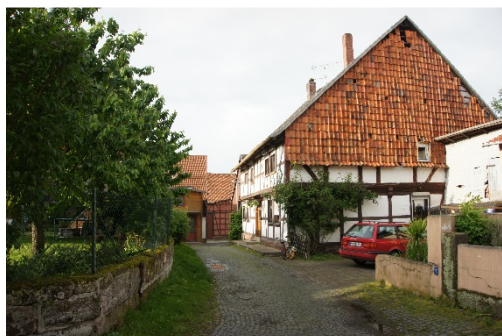
Erneuerungsbedürftiger Behang mit Krepziegeln
