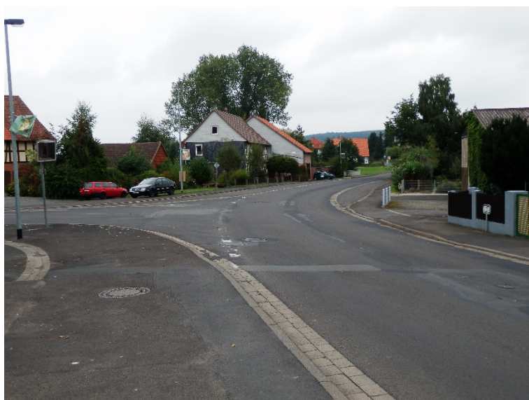
Knotenpunkt Feldtorstraße (K 424) / Behrener Straße aus südlicher Sicht
