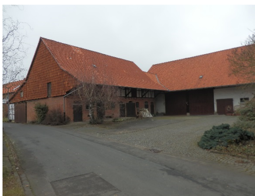
Satteldach mit Hohlziegeln in der Schmiede Straße
