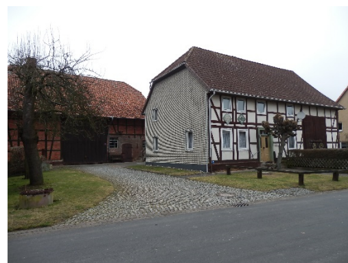
Walmdach vorne mit Betondachpfanne, hinten mit Hohlpfanne Im Siek
