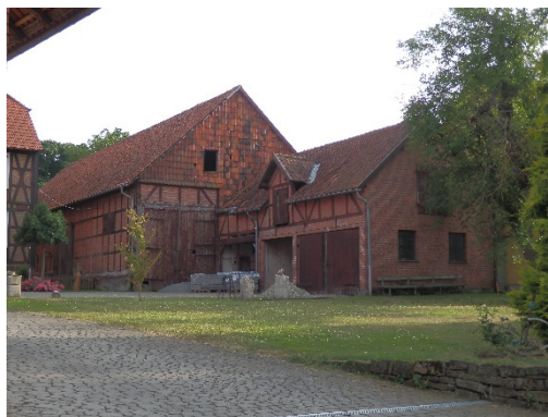
Dacheindeckung mit naturroter Hohlpfanne am Giebel Behang mit Krempziegeln
